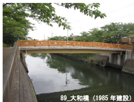
写真 2.2 20 年後に 50 年を経過する橋りょう
