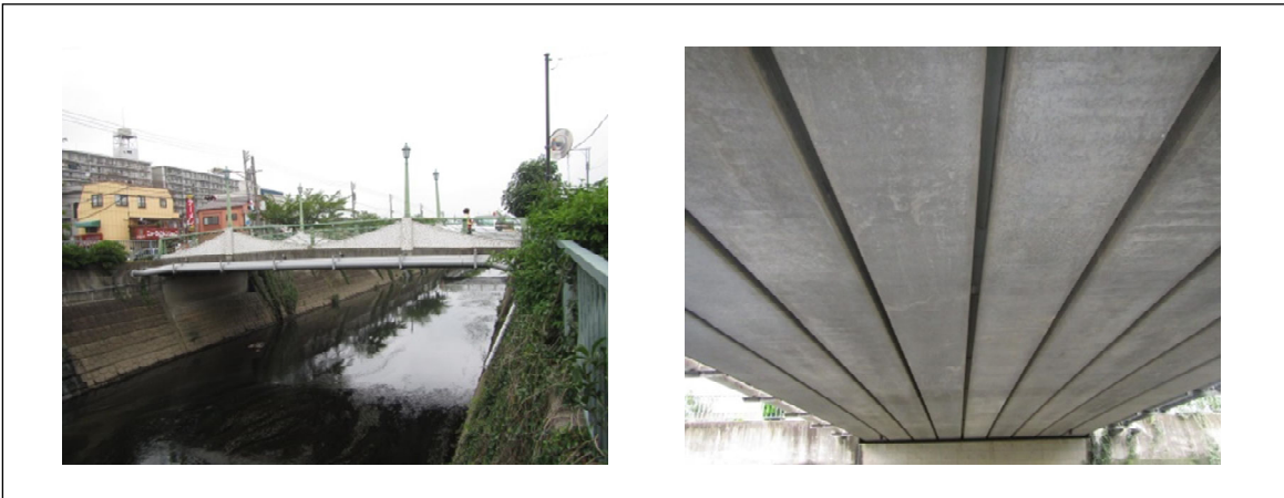
PC橋：48_山之下橋（単純プレテン中空床版橋、橋長 17.3m、大柏川）
