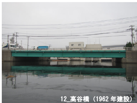
写真 2.1 建設後 50 年を経過する橋りょう
