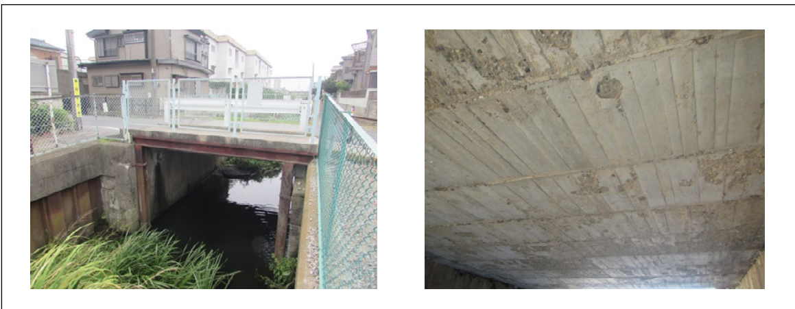
RC橋：41_無名橋（単純RC床版橋、橋長 4.6m、派川大柏川）
