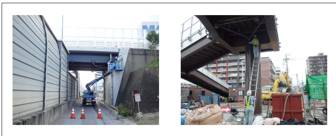
写真 5.1 定期点検状況
