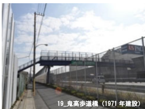
写真 2.1 建設後 50 年を経過する横断歩道橋
