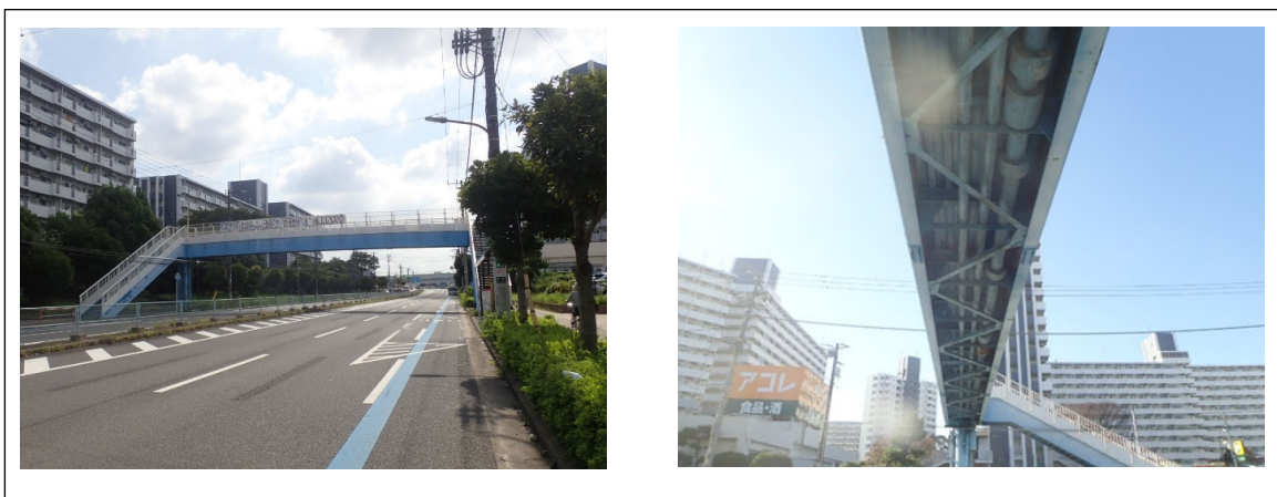
鋼橋：111_原木・二俣歩道橋（単純鋼箱桁橋、橋長 35.6m、市道 0116 号線）
