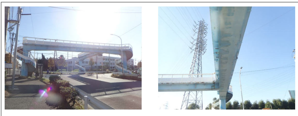
鋼橋：111_原木・二俣歩道橋（単純鋼箱桁橋、橋長 35.6m、市道 0116 号線）
