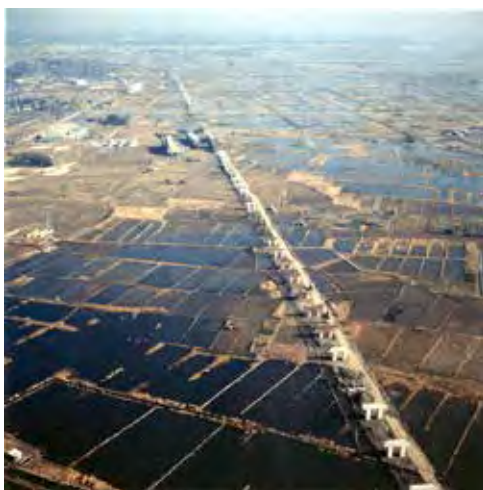
▲東西線工事風景 (写真提供：地下鉄博物館)
