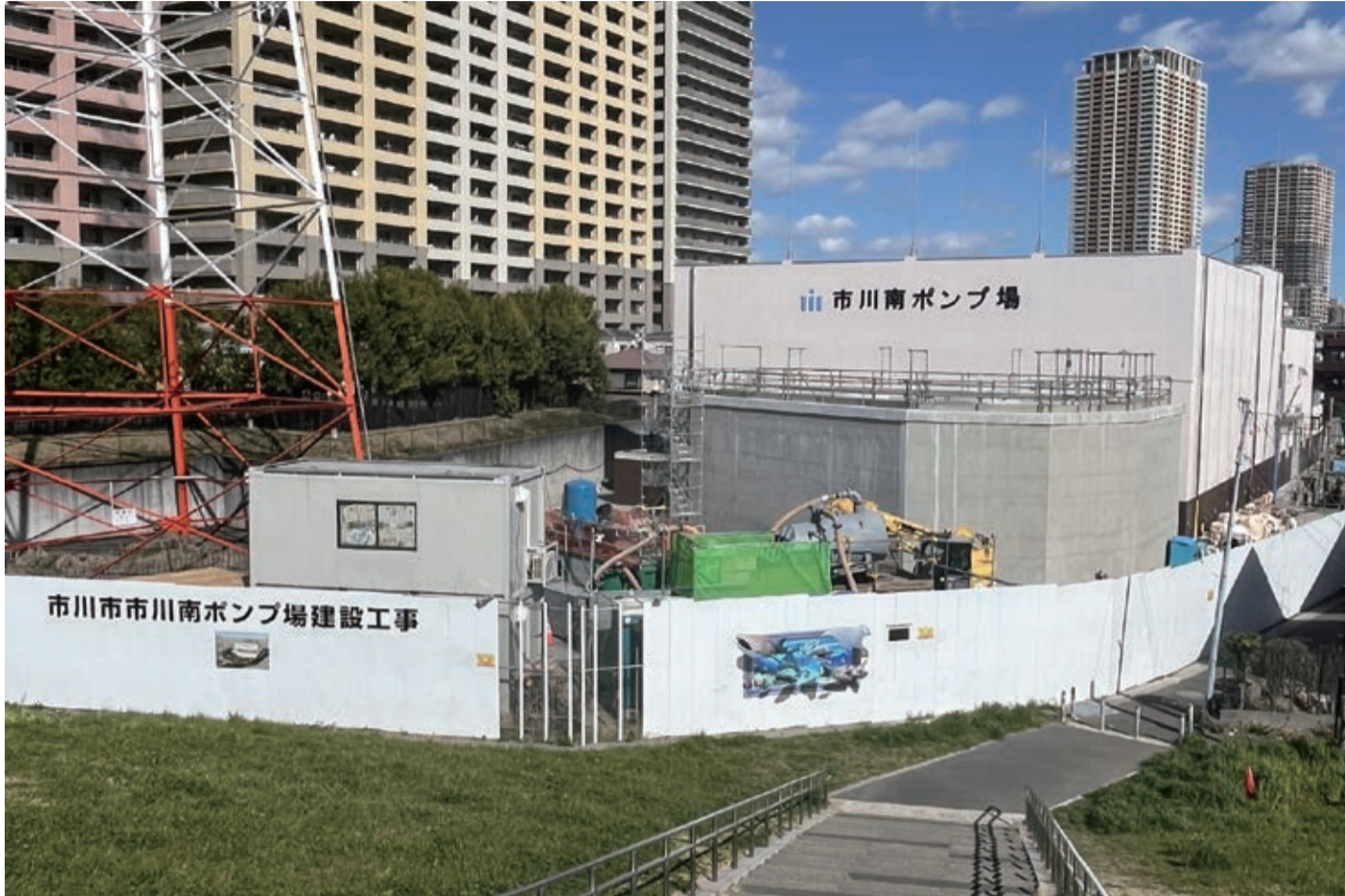
令和9年3月完成予定の市川南ポンプ場
