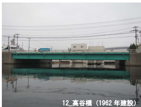
写真 2.1 建設後 50 年を経過する橋りょう
