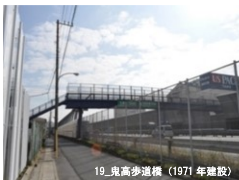
写真 2.1 建設後 50 年を経過する横断歩道橋
