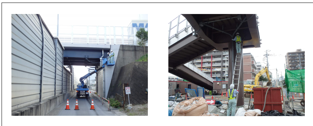
写真 5.1 定期点検状況
