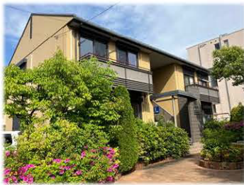
断熱改修を行う 既存賃貸集合住宅
