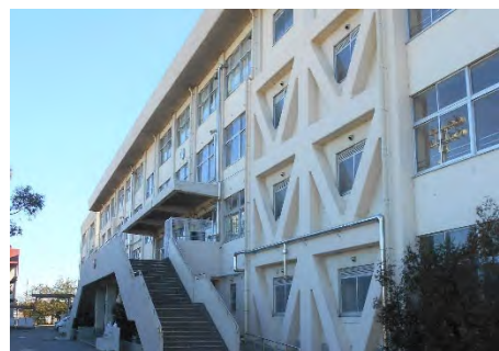
耐震改修の実施
