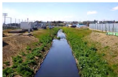
自然環境に配慮した河川改修
