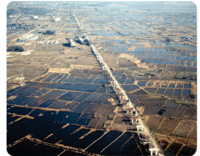
東西線工事の様子 (写真提供：地下鉄博物館)
