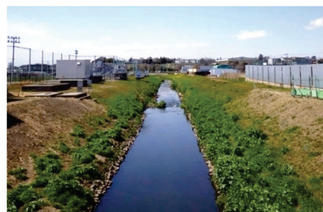
自然環境に配慮した河川改修
