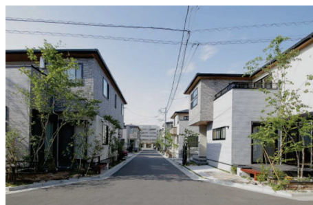
景観協定を活用した住宅地(菅野)のまち並み
