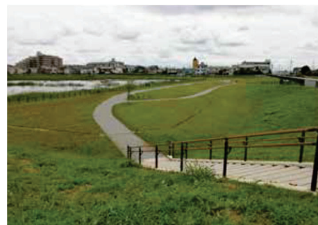
国分川調節池緑地
