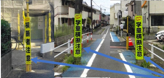
23 木柵看板設置、電柱幕復旧
