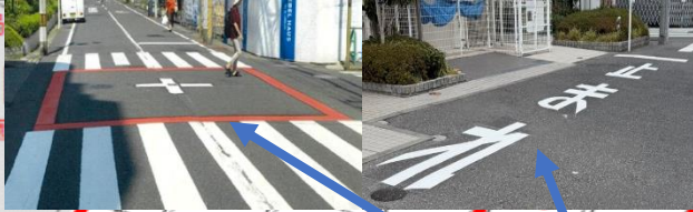
14 カラー舗装及び路面標示の復旧
