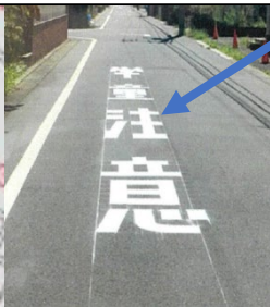
24 路面標示設置
