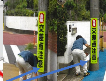
20 電柱幕設置、路面標示復旧
