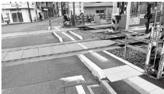
▲歩道の中央部分に点字ブロックを設置しました
