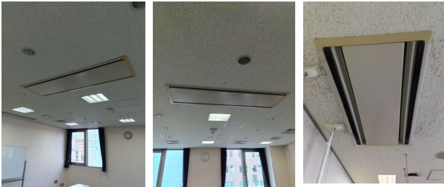
ACP-2-4 (集会室 1) ACP2-5 (集会室 2) ACP2-6 (市民談話室受付)
