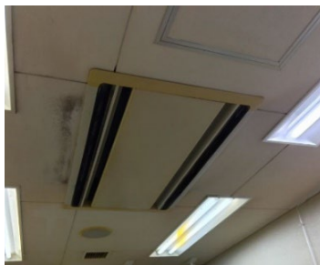
ACP-1-1 (中央監視室)
