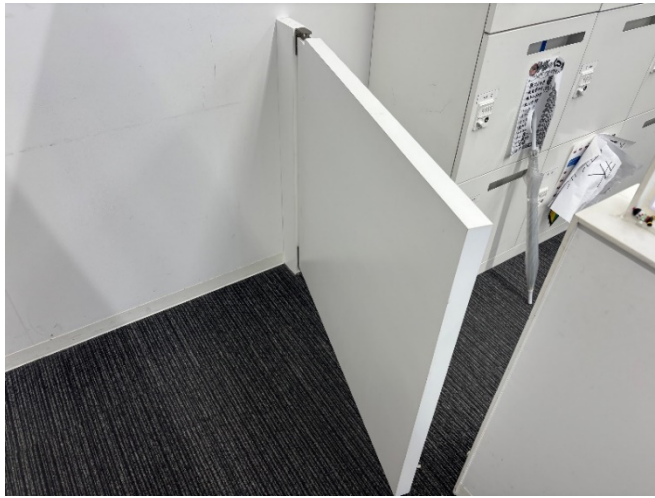
撤去部分②
