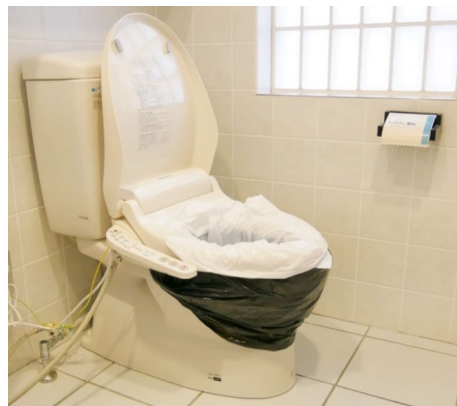
携帯トイレの設置
