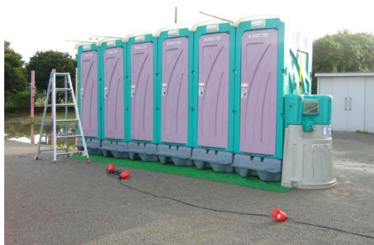
公共スペース（災害用仮設トイレ等）の管理
