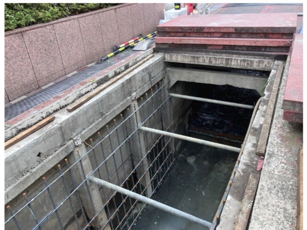
蓋架柵渠改修工事
