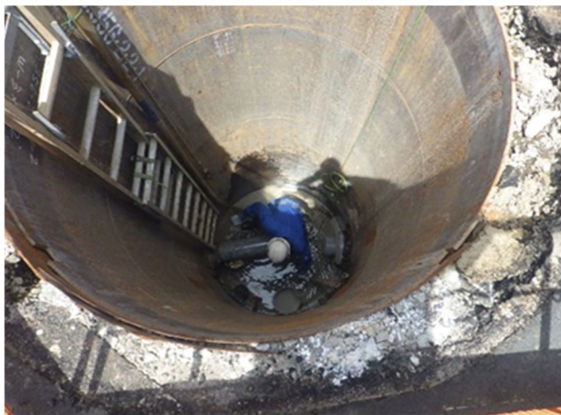
市川第 5-2 処理分区污水管渠工事
