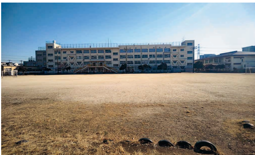
△着工前の屋外運動場
