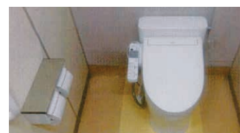
△トイレ改修後
