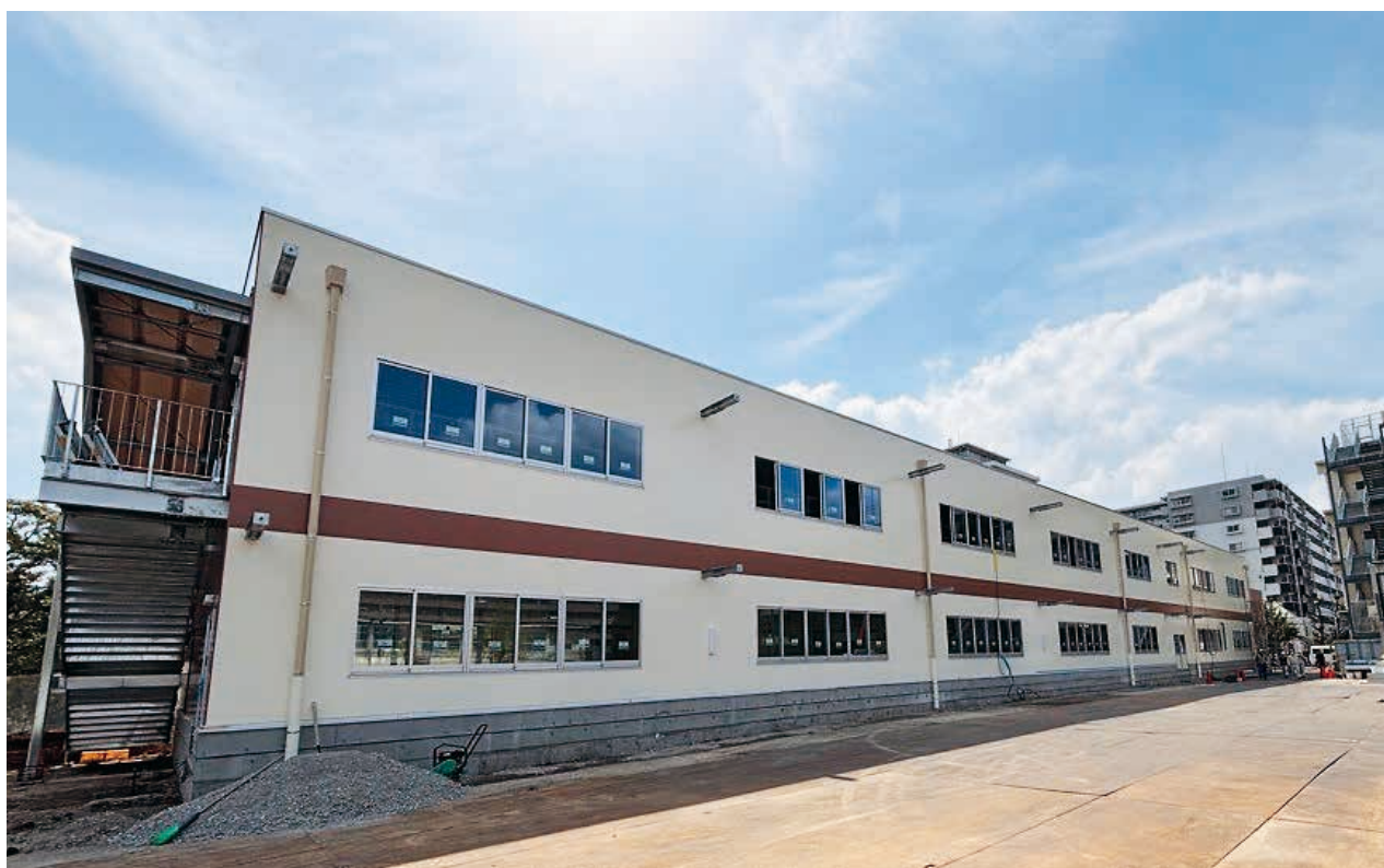
△増築棟北側全景（校庭東側より）
