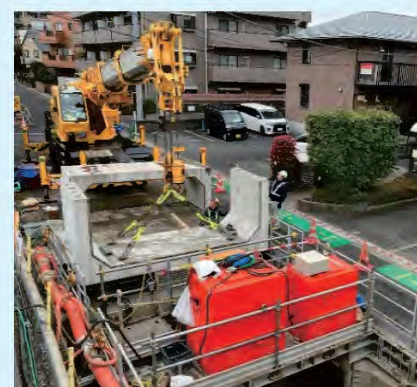
△高谷2号幹線施工状況
