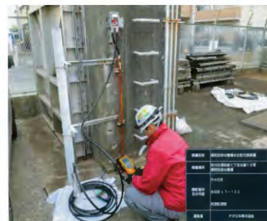
△試運転調整作業
