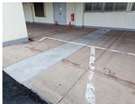
△国府台市民体育館東側屋外污水管外修繕
