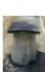
地震時に浮上したマンホール
