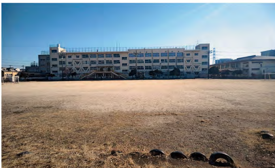
△着工前の屋外運動場
