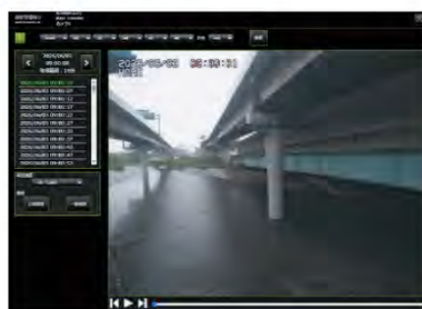
△水防監視カメラ映像（河川）
