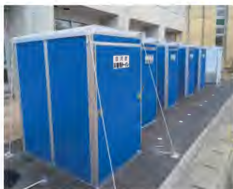
△マンホールトイレ設置状況
