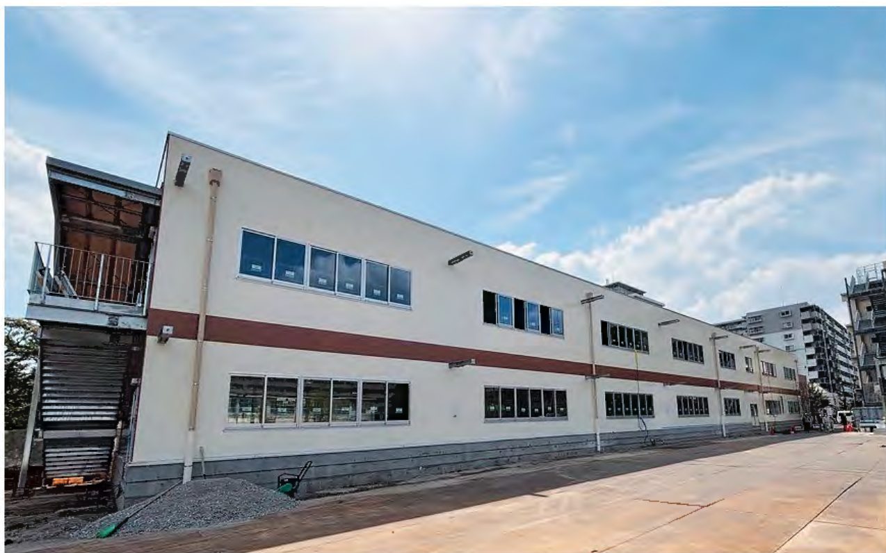
△増築棟北側全景（校庭東側より）
