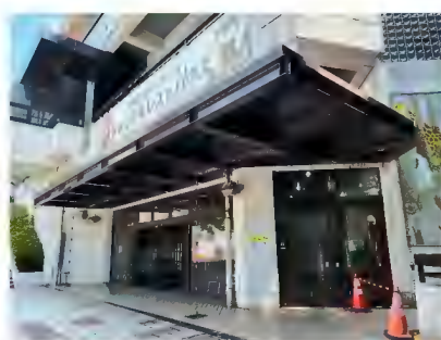
△改修後のレストハウス棟入口屋根
