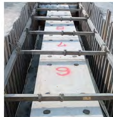
△塩浜地区函渠布設工事状況
