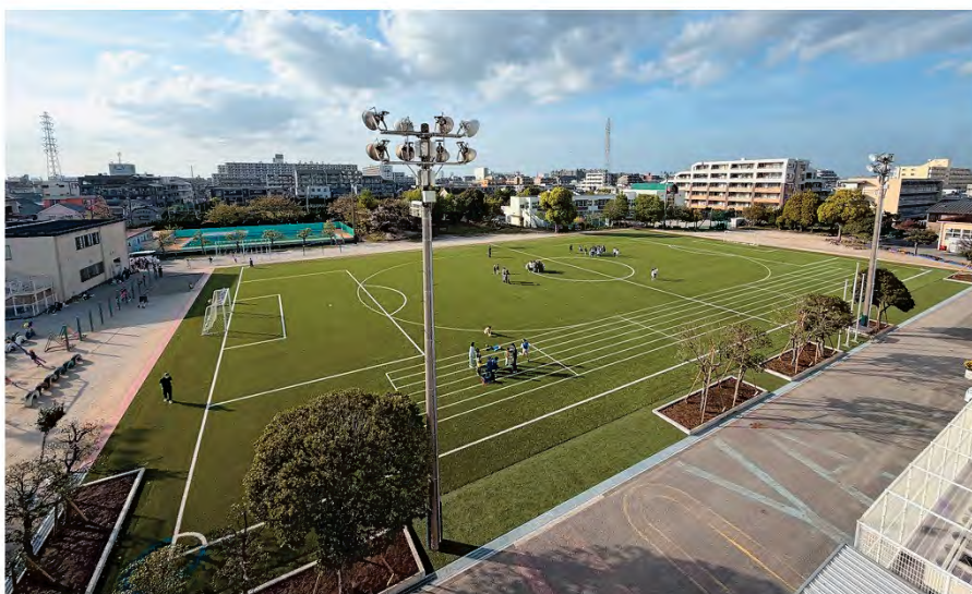
△完成した屋外運動場
