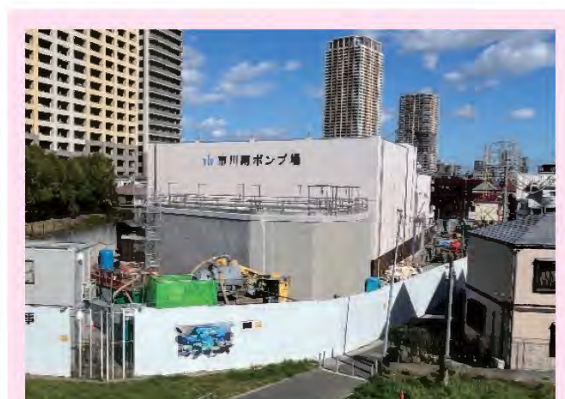
△市川南ポンプ場施工状況
