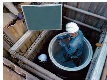
△マンホール設置工
