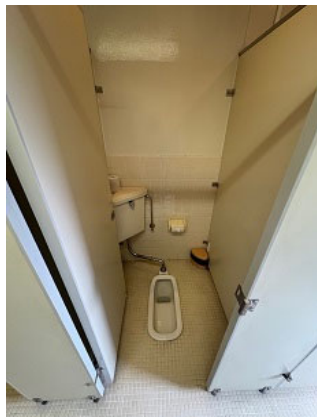
和式トイレ(出入口奥) ブース奥行：108cm ブース幅：94cm
