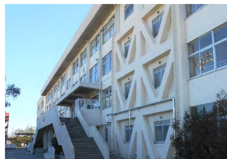
耐震改修の実施
