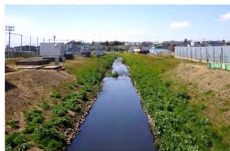
自然環境に配慮した河川改修
