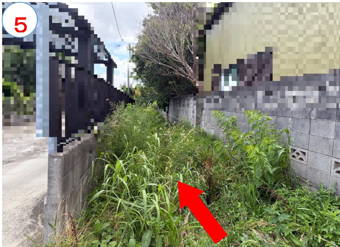
水路入口部分
