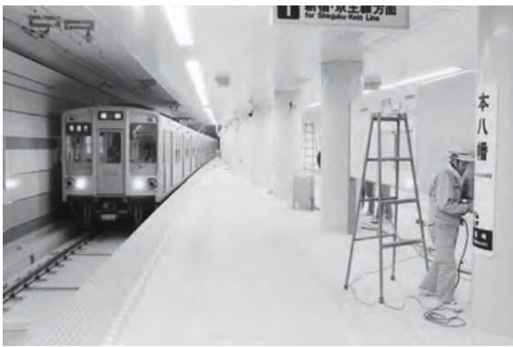
〔2-3-9〕 開業直前の都営新宿線本八幡駅
