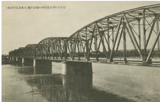
〔2-2-7〕 絵葉書「江戸川に架る近代的の橋市川橋」 (個人蔵) 江戸川橋をやや下流側に移設し、1927年に竣工した
