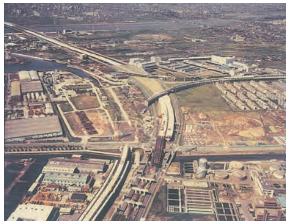
〔2-3-11〕 建設中の東関東自動車道・国鉄 京葉線と東京エアカーゴ・シティ・ ターミナル(1981年) 中央やや右上(京葉線の上)がTACT
