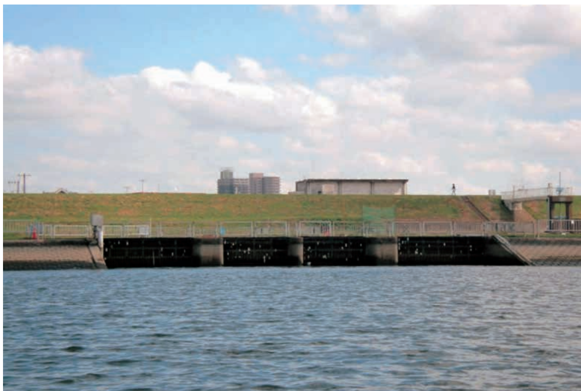
〔3-1-8〕 大和田取水場と取水口 (葛南工業用水道事務所蔵)
