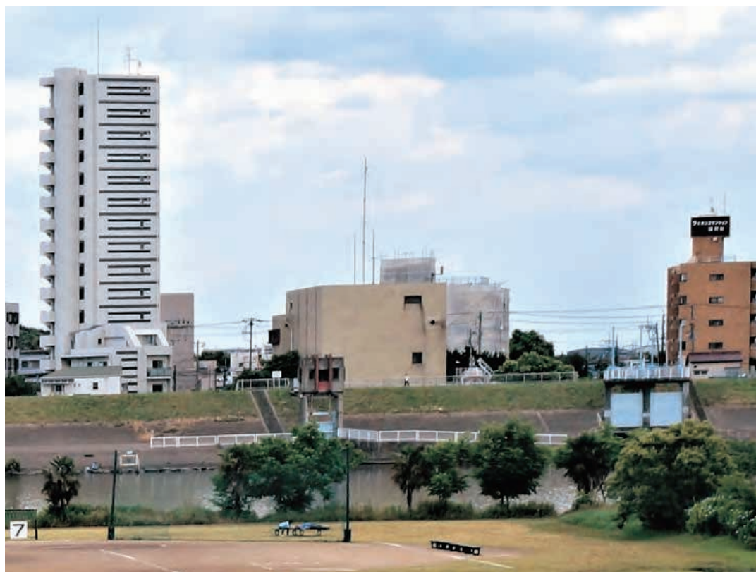
〔3-2-12〕 排水機場と根本水門
