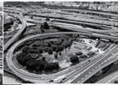
国道357号線と接続する暫定JCT
