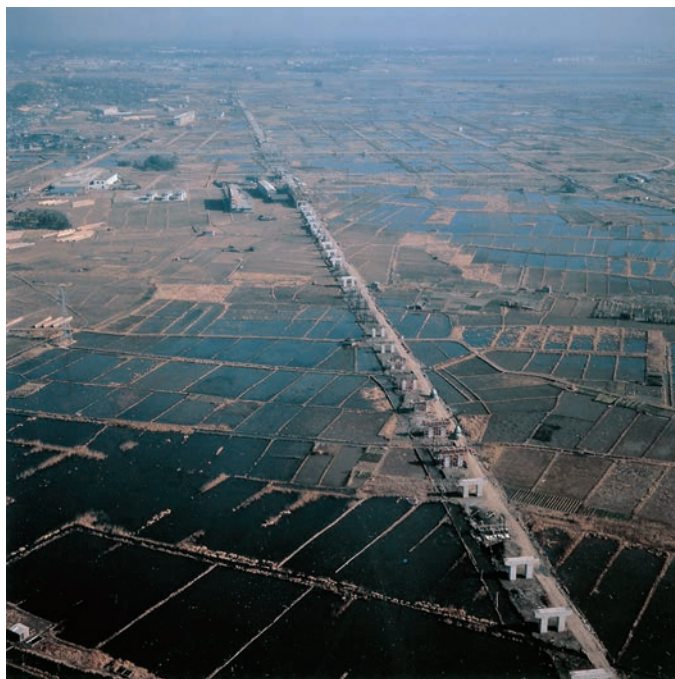
〔1-3-6〕 東西線建設中の行徳地区（1968年頃） （地下鉄博物館蔵）
